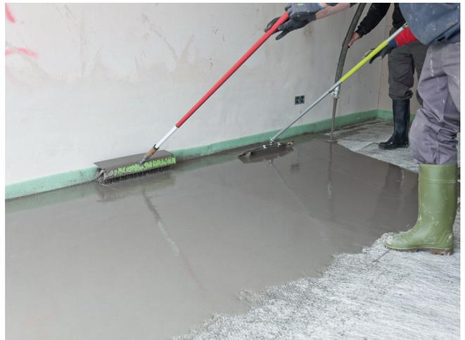
L'enduit de dressage UZIN NC 160 est mis en œuvre sans effort à la lisseuse ou au râteau d'étalement. La poudre se mélange facilement pour former une consistance sans grumeau et sa très bonne propriété autolissante représente toujours une base exceptionnelle pour les travaux suivants. En construction neuve comme en rénovation sur support ancien.
